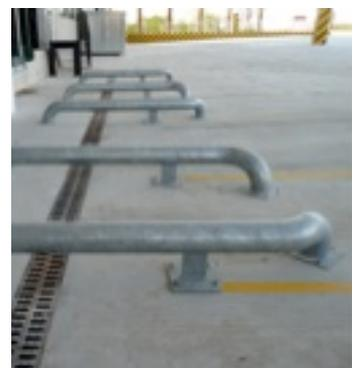
Easy line sono la coppia di guide di centraggio in acciaio zincato che completano in modo moderno ed efficiente il punto di carico. L'impiego delle guide sia nella versione 1 che 2 obbligano i mezzi ad attraccare sempre perpendicolarmente rispetto alla banchina di carico e l'accosto avviene sempre in perfetto asse con la pedana di carico.
