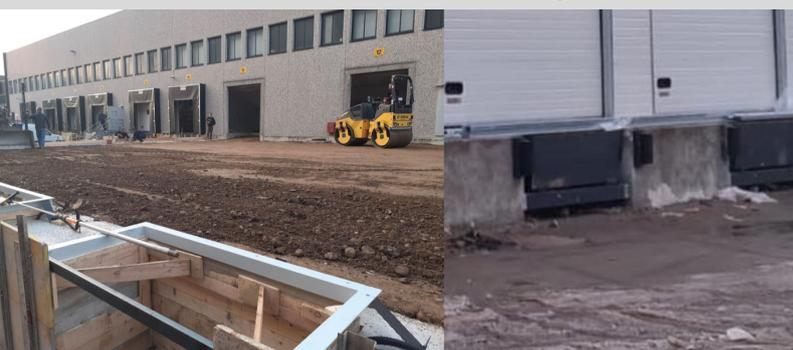
Questa modalita', prevede la fornitura di un telaio angolare che il cliente deve fare premurare. Seguendo le indicazioni tecniche del nostro ufficio, viene cosi realizzata una «fossa» entro la quale si installa successivamente la componente mobile del MINIDOCK PA2P.
