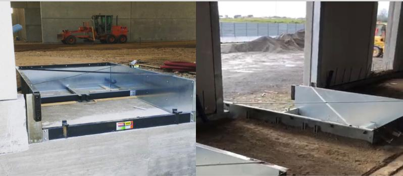
Da assemblare in opera, deve essere stabilizzata e riempita sul perimetro. Gettato il pavimento si posiziona il pianale della pedana e viene realizzato l'impianto elettrico ed idraulico. Tempo di esecuzione tra assemblaggio e messa in bolla ca. 40'.
