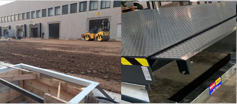
In profilo angolare 80x80 fornito in tre pezzi da assemblare in opera, da stabilizzare sopra la fossa precedentemente realizzata e poi da integrare nel getto del pavimento. A seguire si posiziona la pedana. Tempo stimato di esecuzione tra assemblaggio e messa in opera armatura in legno ca. 180'. Abbinare il modello di pedana PA2P-AP.
