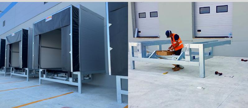
Non vengono eseguite opere edili all'interno dell'edificio. Si predispone un angolare a bordo vano in corrispondenza della porta sezionale. Applicato in appoggio al pavimento esterno e con saldatura all'angolare posteriore predisposto, il dock viene allestito nelle differenti configurazioni disponibili nel catalogo.
