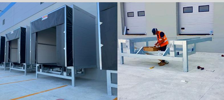
Non vengono eseguite opere edili all'interno dell'edificio. Si predispone un angolare a bordo vano in corrispondenza della porta sezionale. Applicato in appoggio al pavimento esterno e con saldatura all'angolare posteriore predisposto, il dock viene allestito nelle differenti configurazioni disponibili nel catalogo.
