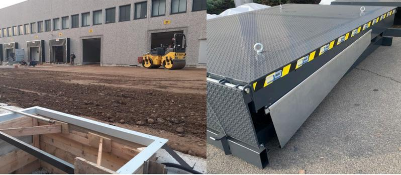
In profilo angolare 80x80 fornito in tre pezzi da assemblare in opera, da stabilizzare sopra la fossa precedentemente realizzata e poi da integrare nel getto del pavimento. A seguire si posiziona la pedana. Tempo stimato di esecuzione tra assemblaggio e messa in opera armatura in legno ca. 180'. Abbinare il modello di pedana PA2P-AP.
