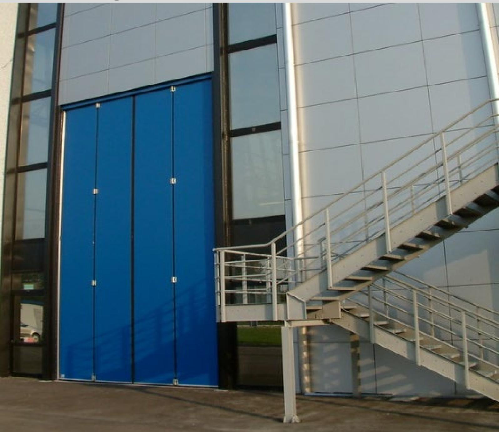
Tante applicazioni possibili nei piu' differenti ambiti architettonici e lavorativi. Molto utilizzato per la chiusura di vani che non necessitano di passaggi frequenti e che l'agevole movimentazione manuale lo fa preferire a soluzioni motorizzate molto piu' onerose.
