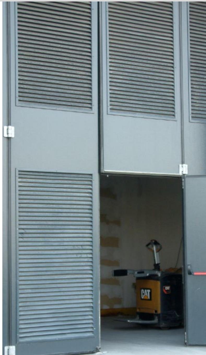
Gli oblo' possono essere con cornice in alluminio con spigoli a 90° e vetri camera di varie tipologie. Le griglie vengono realizzate zincate, nere oppure verniciate in tinta ral come l'anta del portone.
