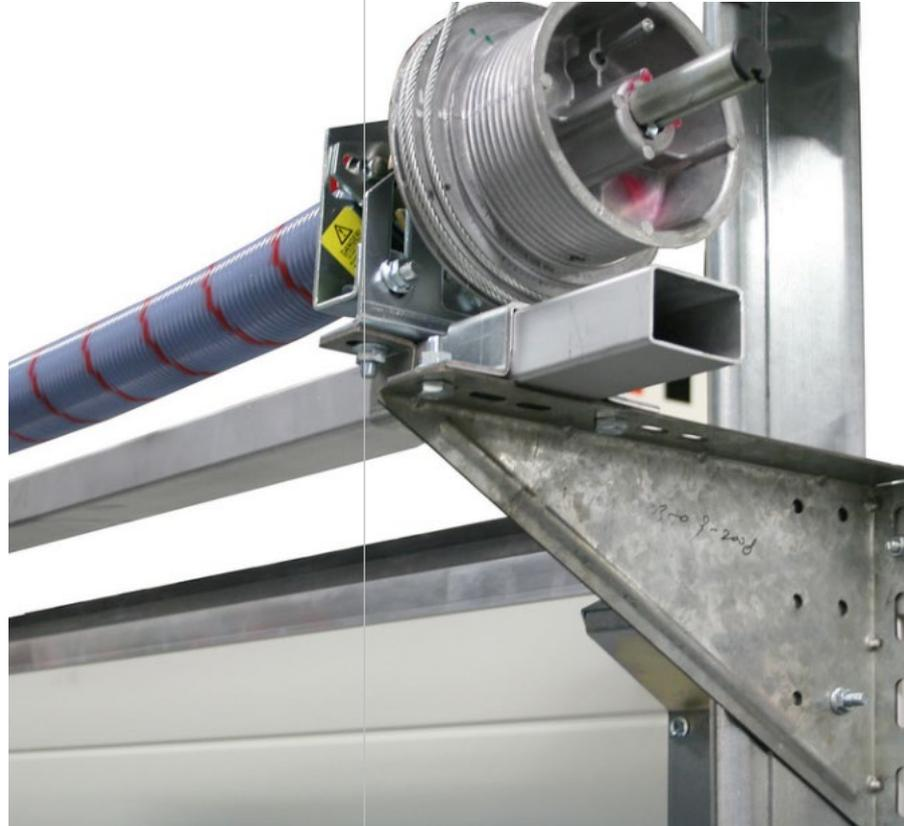
**Scorrimento totalmente verticale VER-RIB.** La porta scorre aderente al muro in modo completamente verticale. Architrave necessario : H vano +700 mm.
